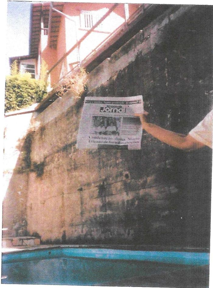
Fotografia da casa do meu vizinho, em cor rosa, e o muro de contenção que ele construiu sem projeto aprovado, observando-se na parte direita desta as infiltrações que ocorriam através deste muro.
